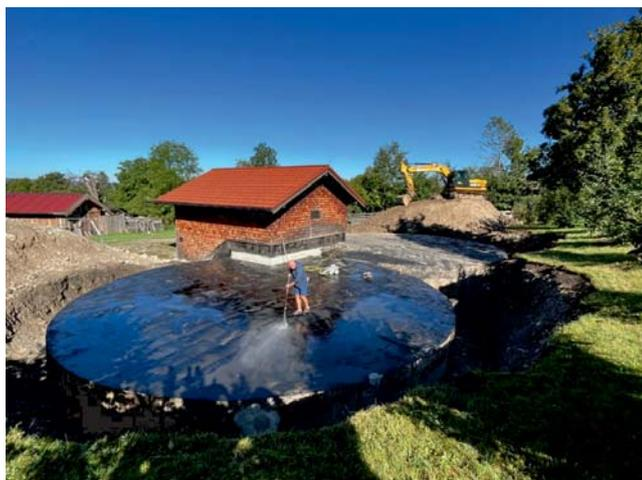
Nach einer äußerst gründlichen Reinigung der Außenschicht, konnte bereits die erste neue Dichtungsschicht aufgebracht werden. Nun erfolgt der weitere Aufbau, der letztendlich eine Stärke von insgesamt ca. 30 cm betragen wird.
