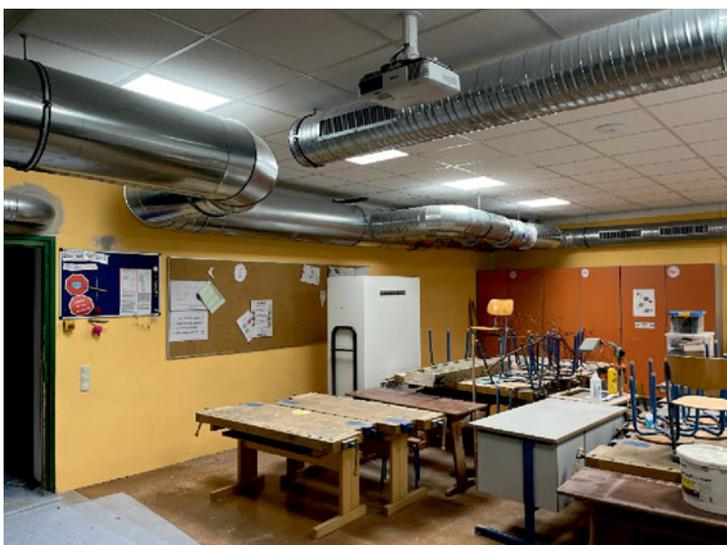
Rohrleitungen mit Schalldämpfer im Werkraum im Keller
